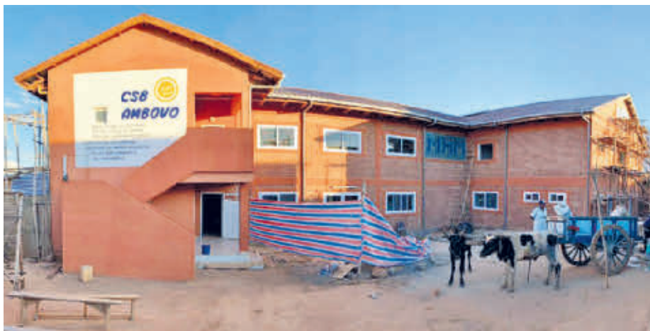
Das Krankenhaus in Madagaskar während der Bauphase.
